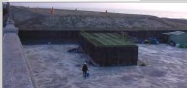
茄萣鄉垃圾衛生掩埋場封場照片
